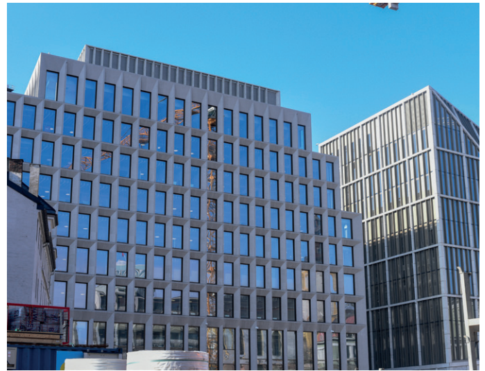
Fasaden i D-blokka er kledd med store fasadeelementer av Iddefjordgranitt.
