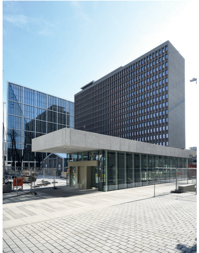
Mellom H-blokka og G-blokka er det også bygget en inngangspaviljong til et nytt, permanent 22. juli-senter.
