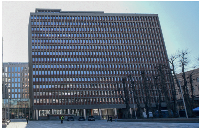
Fasaden mot Johan Nygaardsvolds plass og Akersgata er rehabilitert med gjenbrukt teak.
