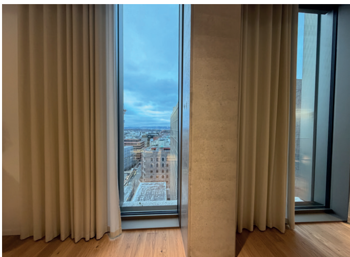
I både byggeprosessen og i selve bygget er det lagt mye arbeid i å sørge for god objektsikkerhet. Foto: Frode Aga
